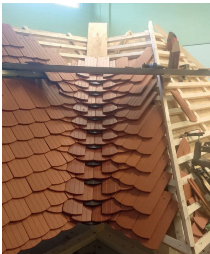
Acht Kehlen wurden mit Biberschwanz-Dachziegeln eingedeckt.
